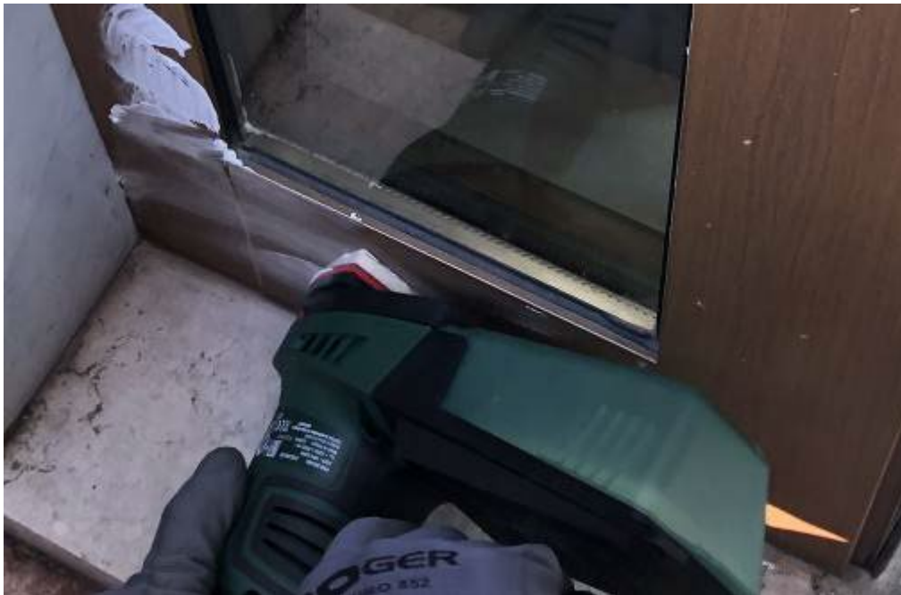
Figura 3: Distensione del PM 02-03-0001 sulla superficie da trattare
